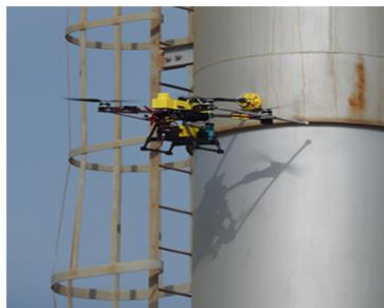
Drone aérien effectuant des tests par ultrasons sur une tour de raffinage.
