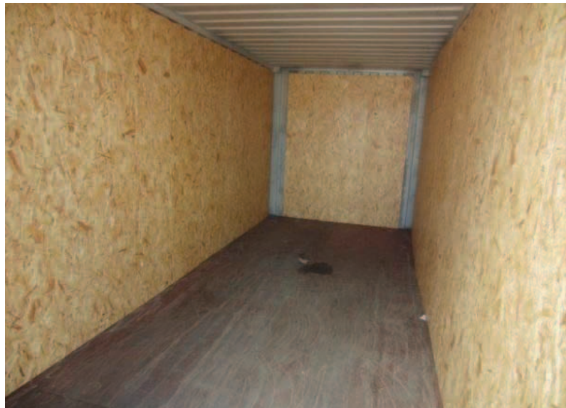
Figura 7.53: Revestimiento de un contenedor de 40 pies con paneles de cartón usado
