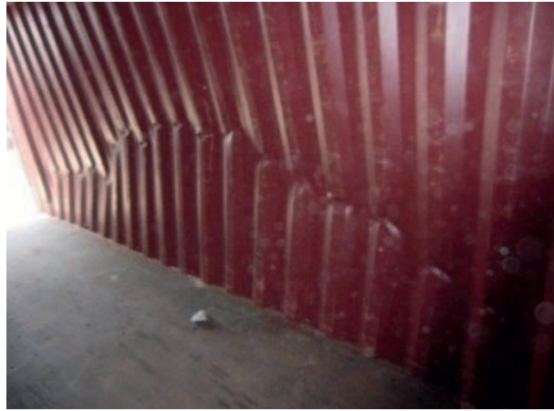
Figura 7.50: Pared lateral dañada de una unidad de transporte
