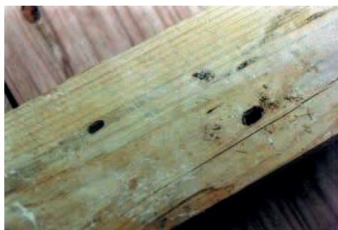
Figura 6.13: Virutas de la madera de insectos perforadores
