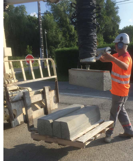
Figures 37 et 38. Système de préhension par succion pour soulever des bordures de trottoir
