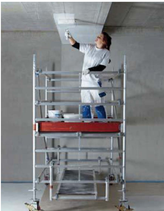
Figure 16. Echafaudage mobile correctement monté en cours d'utilisation
