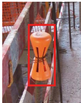
Figure 6. Tiges de renforcement protégées; le risque d'empalement est contrôlé
