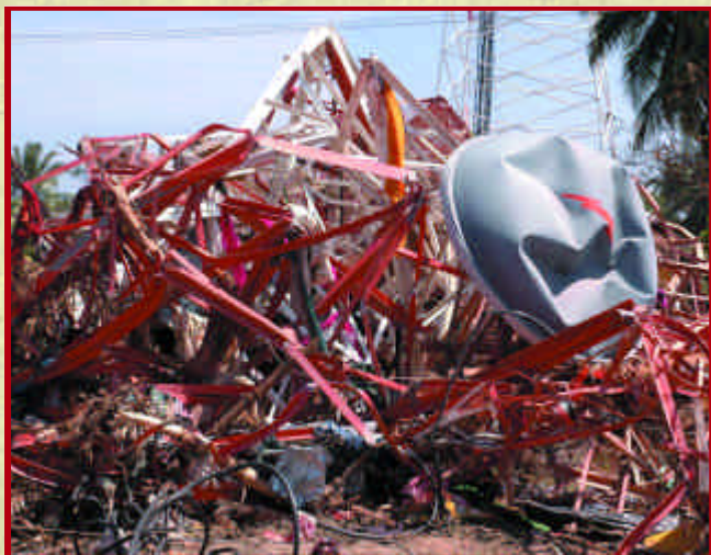
Des ouvriers débarrassent les débris à Hambantota et ont même reconstruit la tour de communication.
