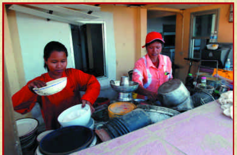
Khao Lak : un mois après le tsunami, remise en état d'un restaurant du bord de mer, par des propriétaires et des employés qui espèrent une réouverture rapide.
