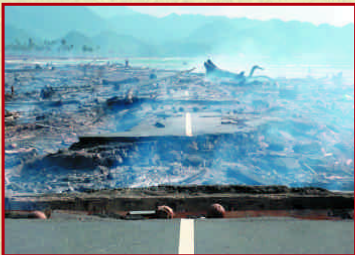
Le réseau routier a été très endommagé. La reconstruction de l'infrastructure de base procurera des emplois et des revenus aux chômeurs.
