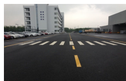
厂区道路和人行道
