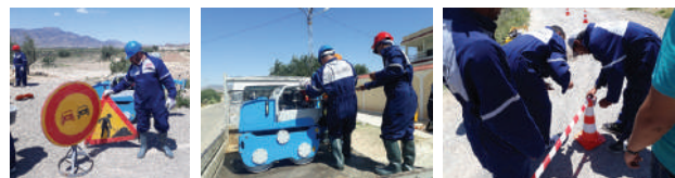
► Formation théorique et pratique sur les mesures de sécurité à prendre pour la reprise des chantiers
