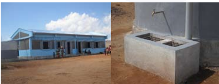
Construction d'écoles primaires par le Projet BIT-HIMO
